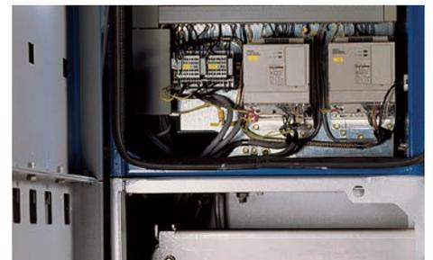
Frequenzsteuerung an den Fahr- und Hubantrieben für schonenden Sanftlauf und stufenlos regelbare Geschwindigkeiten. Bauteile werden weniger beansprucht, die Anlage läuft sanft, Kunden empfinden die Anlage als sicher.
