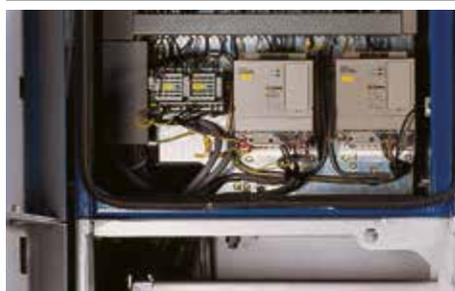
Les variateurs de fréquence, qui équipent les moteurs de translation et de levage, permettent un démarrage en douceur et un réglage progressif des vitesses. Les composants sont moins sollicités, l'installation se déplace sans à-coups, procurant ainsi un sentiment de sécurité au client.
