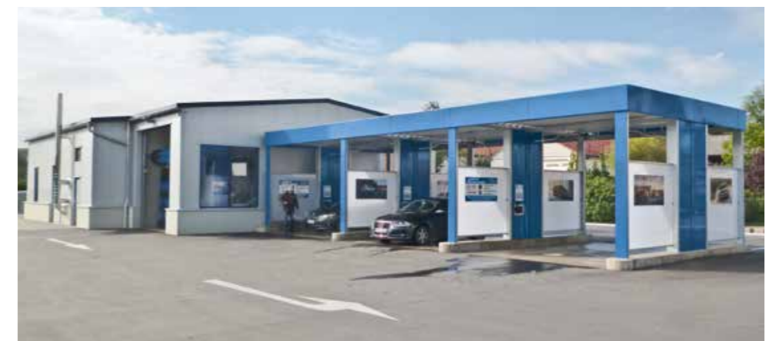
Stahlbau Compact: die kostengünstige Lösung in Flach- oder Runddachausführung (Flachdach mit Attika). Eine Kombination aus Portal- und SB-Waschplätzen
