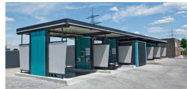
Flachdach mit Attika
