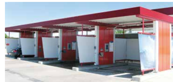
Tetto piano con bordatura alta
