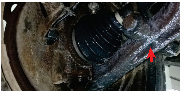
Korrosionsschutz bei Achsträgern
