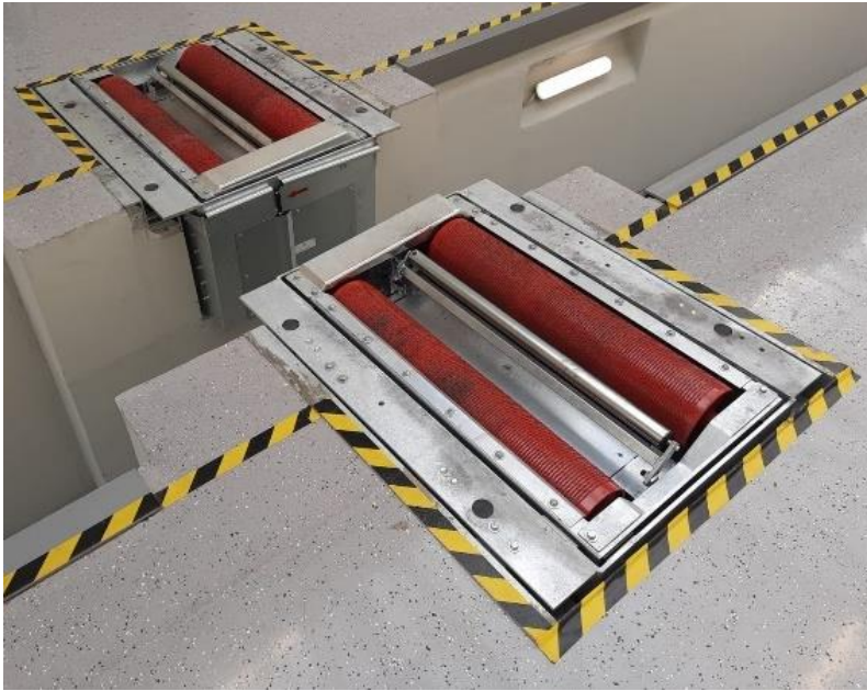
Einbau unterflur, mit Arbeitsgrube Bauweise Twin
